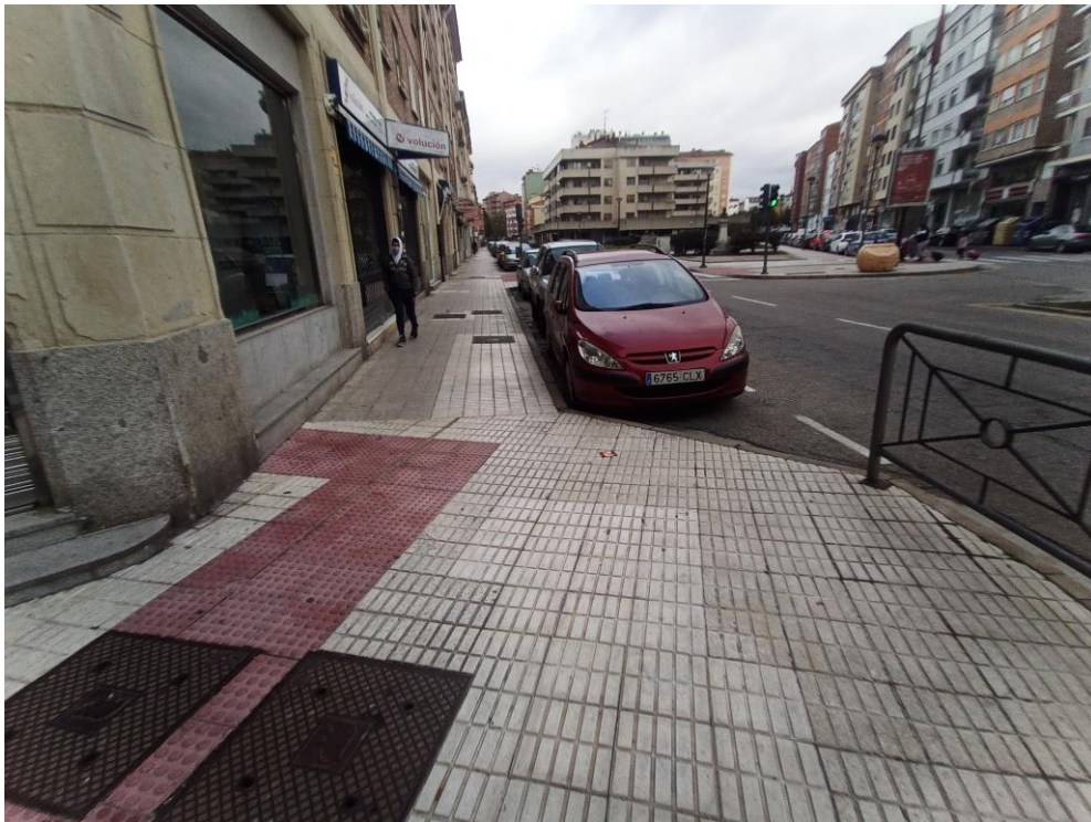
FOTO 2 Extremo este del ámbito de actuación.
