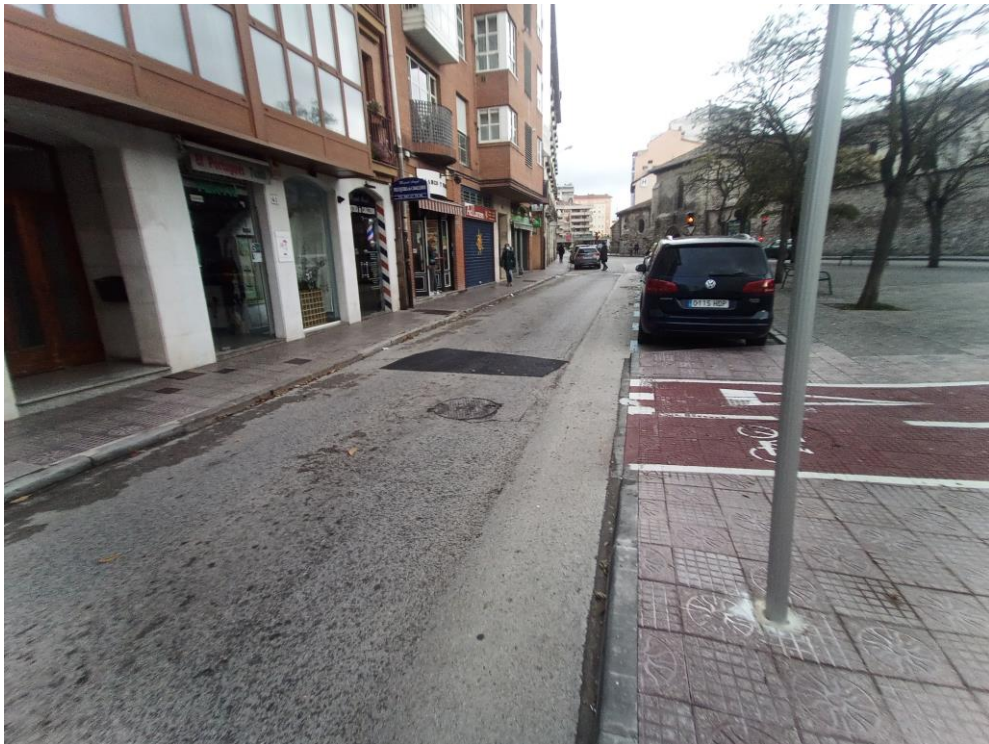
FOTO 14 Vial y edificaciones en acera norte de calle Santa Clara.
