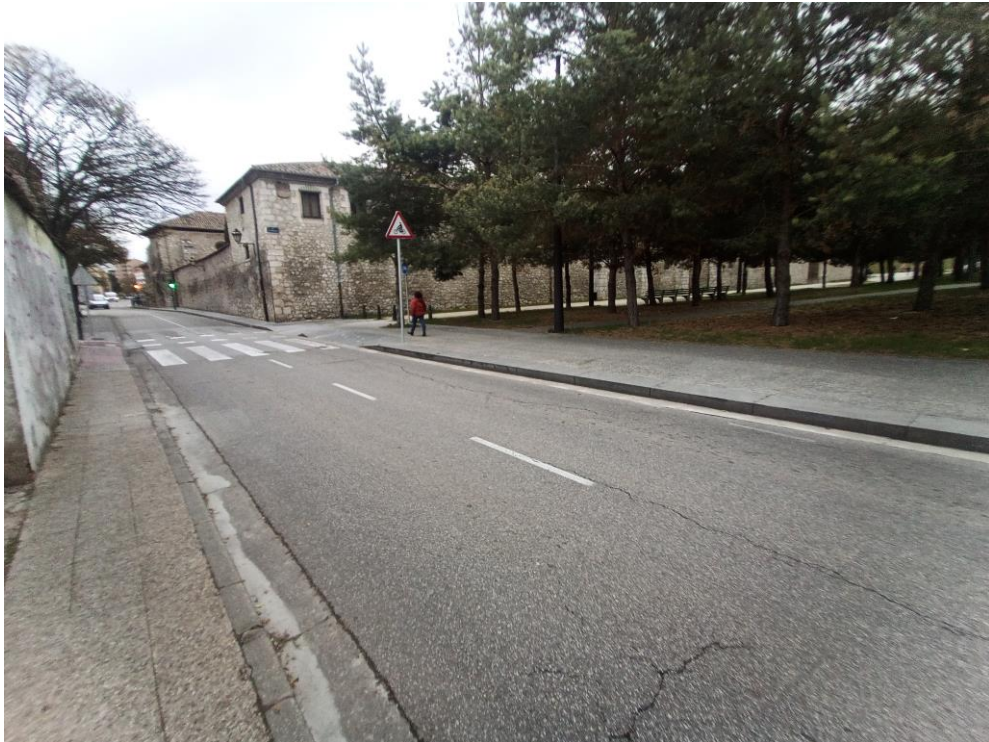
FOTO 18 Vial actual y acera sur de la calle Progreso.
