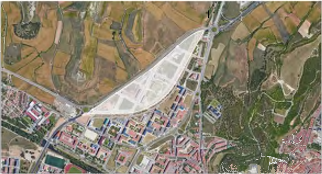
Ubicación de la UA S7-1 "Fuentecillas Norte" en su entorno próximo
